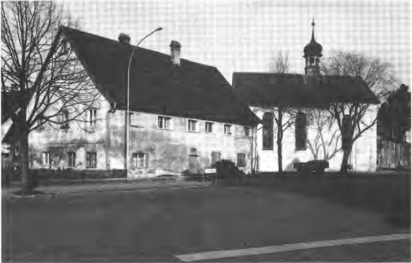
Das "Siechenhaus" und die "Siechenkapelle" in Bregenz am ehemaligen Stadtrand. Bis ins 20. Jahrhundert verwendet, belegt dieses Gebäude eindringlich die lokale Kontinuität bei der Unterbringung von Kranken .
