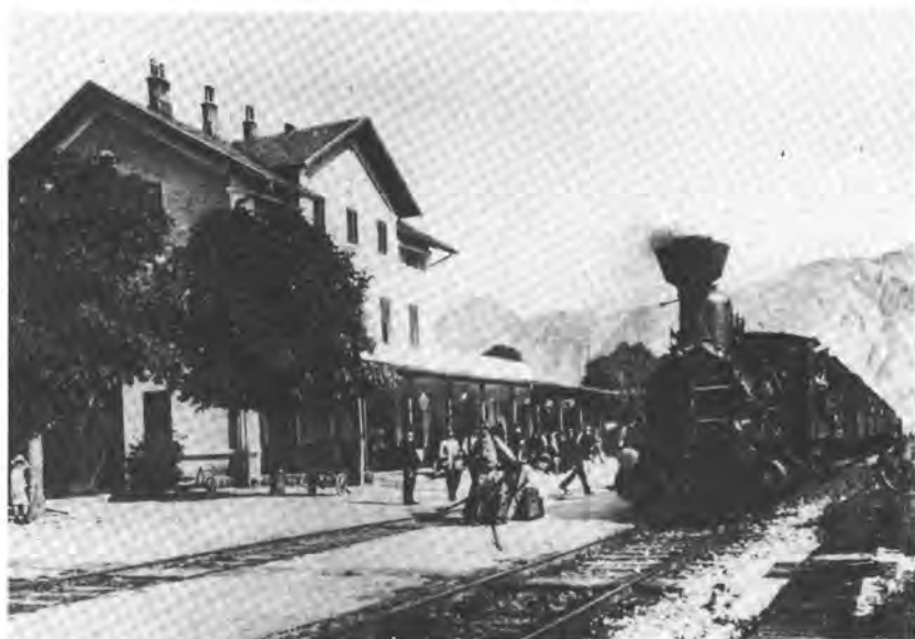
Bahnhof von Borgo um 1910: zentrale Bahnstation für trentinische Arbeiterinnen und Arbeiter bei der Auswanderung nach Vorarlberg
