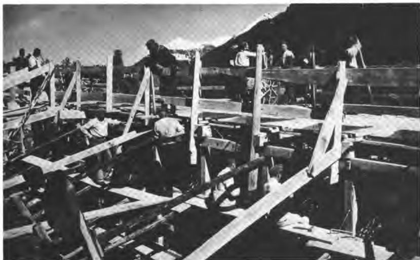
Zwangsarbeiter beim Einsatz – unter militärischer Überwachung: Betonierungsarbeiten beim Stausee Rodund, Herbst 1941
