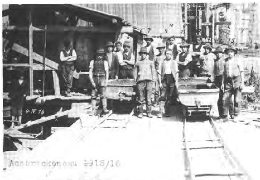
Kriegsjahr 1915/16: Die arbeitsfähigen Männer sind eingezogen, die hier abgebildeten Arbeiter beim Bau der Lauteracher Achsbrücke sind durchwegs Jugendliche zwischen 14 und 18 Jahren.
