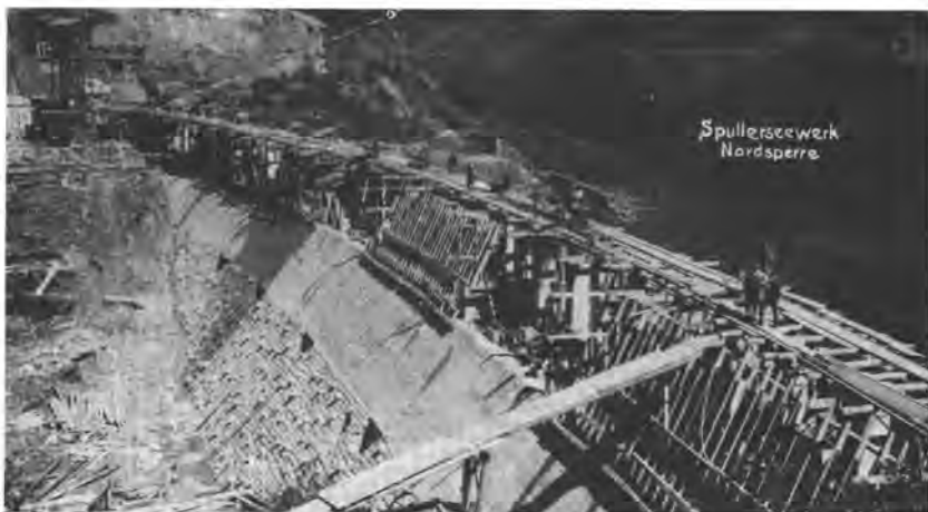
Abb. 1: Baustelle des Spullerseewerkes (1820 m)
