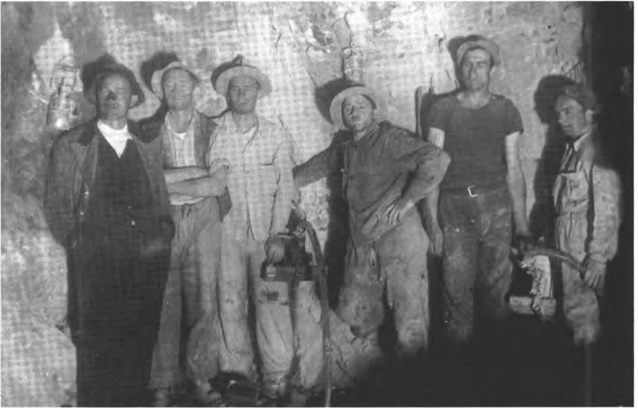
*Gleichzeitig mit der Staumauer mußten weitere Bauprojekte in Angriff genommen werden, um die Stromgewinnung und den Stromexport in Gang zu bringen. Dazu gehörte die Aussprengung des Druckstollens ebenso wie die Erstellung der Überlandleitungen. Im Stollen- wie im Tunnelbau spielten die Mineure (oben Tunnelbau in Hochkrumbach um 1932) die wichtigste Rolle. Bohren, laden, sprengen hieß der Dreitakt ihrer gefährlichen Tätigkeit, die im Schnitt etwas besser bezahlt war als andere Arbeiten am Bau.*
