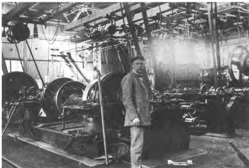
Staatsbahn-Werkmeister Adolf Kalas, ein führender Funktionär der örtlichen SDAP, in Sonntagskleidung an seinem Arbeitsplatz. Im Hintergrund Drehbänke, darunter eine zur Bearbeitung von Waggon- und Lokomotivrädern.
