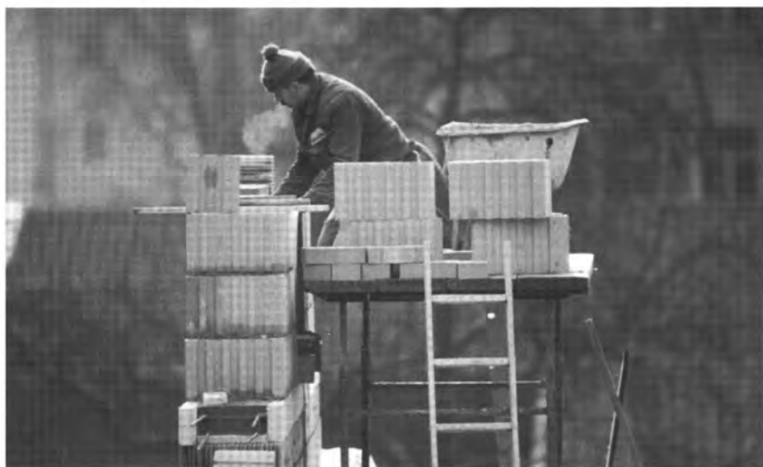
Türkische Arbeiter sind von Vorarlberger Baustellen schon lange nicht mehr wegzudenken.
